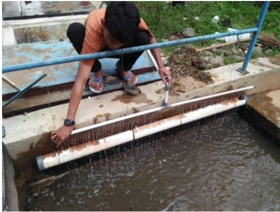
Gambar 6. Pemasangan Sistem Pre Chlorinasi di Intake
