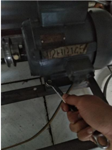
Gambar 17. Pemasangan Motor Listrik
