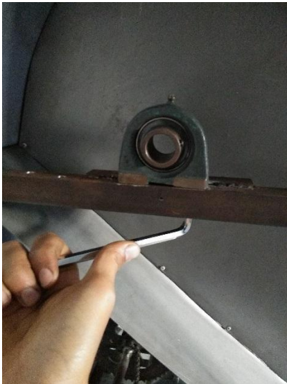
Gambar 13. Pemasangan Dudukan Bearing
