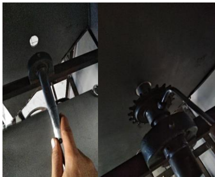
Gambar 14. pemasangan poros dan gear kecil
