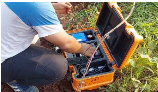
Gambar 15: Penyambungan Kabel Fiber Optik Secara Temporer
