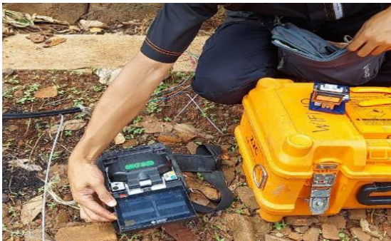
Gambar 14: Penyambungan Kabel Fiber Optik Secara Temporer
