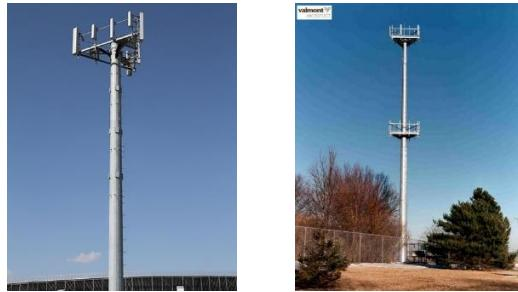
Gambar 3: *Monopole* jenis *Circular pole* (kanan) dan *Tapered pole* (kiri)
