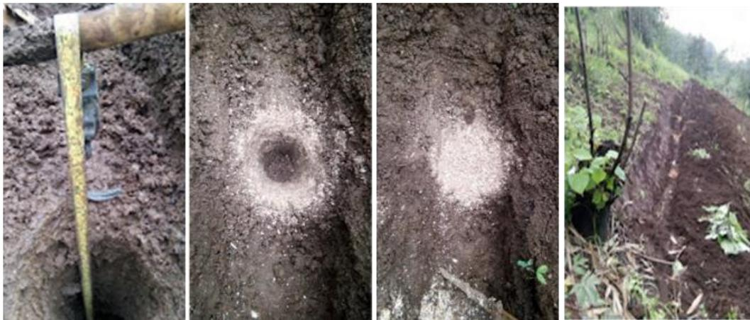
**Gambar 7: Dokumentasi Pembuatan Lubang Biopori**
